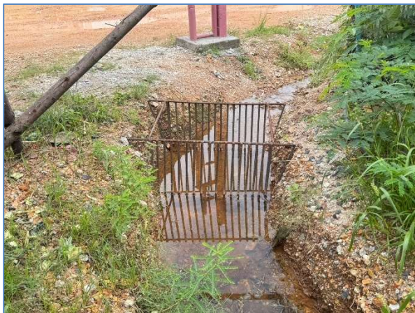
รูปที่ 2.2.1-19 ตะแกรงดักขยะ
