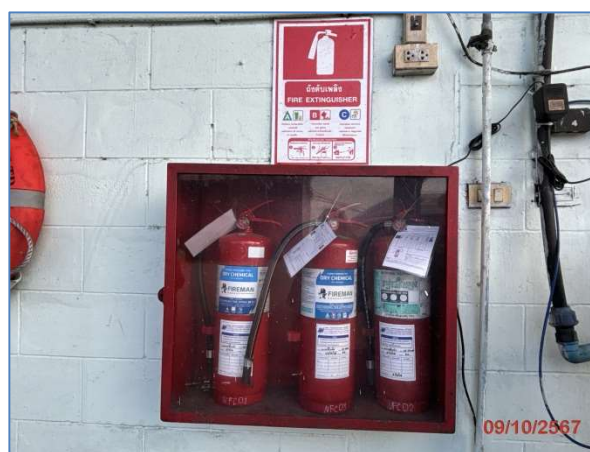
รูปที่ 2.2.2-23 อุปกรณ์ป้องกันและระงับอัคคีภัยภายในพื้นที่ท่าเรือ
