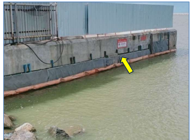
รูปที่ 2.2.1-20 ม่านกันตะกอนบริเวณก่อสร้างปั้นจั่นหน้าท่า
